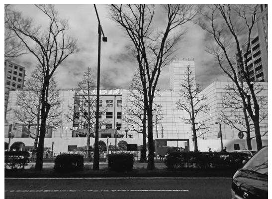
市役所本庁舎解体工事（4月7日現在）
