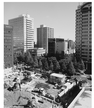
解体が進む市役所本庁舎 （7月11日 現在）
