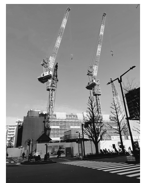
市役所本庁舎建設工事の状況（2021/12/16）
