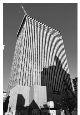
建設中の新庁舎(2022/12/15撮影) ※11月11日記事参照
