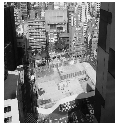
解体を終えた市役所本庁舎 （10月10日現在）
