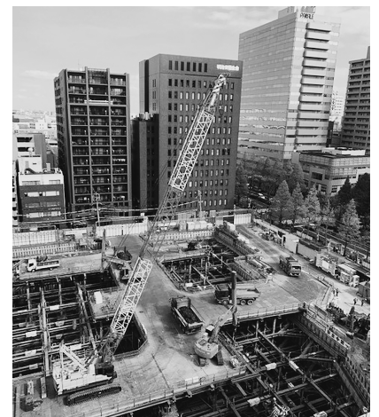
市役所本庁舎 建設工事の状況 地下と1階部分の枠組みができつつある(2021/4/12現在)
