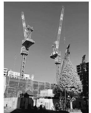
市役所本庁舎建設工事の状況 地表から見た写真 鉄骨が立ち上がってきた (2021/10/20現在)
