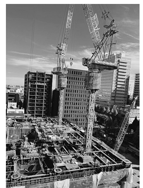
市役所本庁舎建設工事の状況 上から見た写真 (2021/10/20現在)
