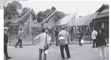
急傾斜の太陽光パネル
